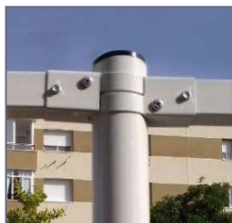
Detalle brida para tubo redondo de \varnothing 60 mm.
